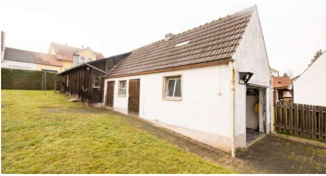
Nebengebäude mit Lagerraum und Werkstatt
