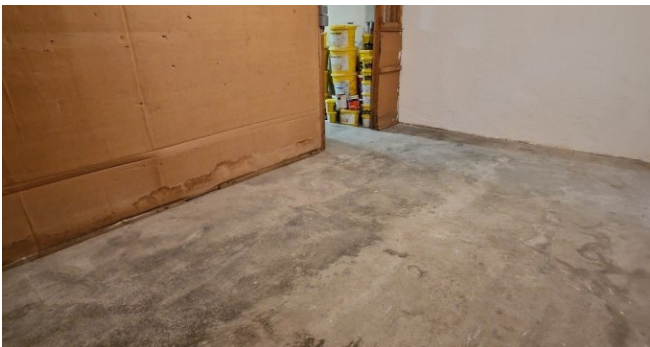
Keller mit Stromanschluss
