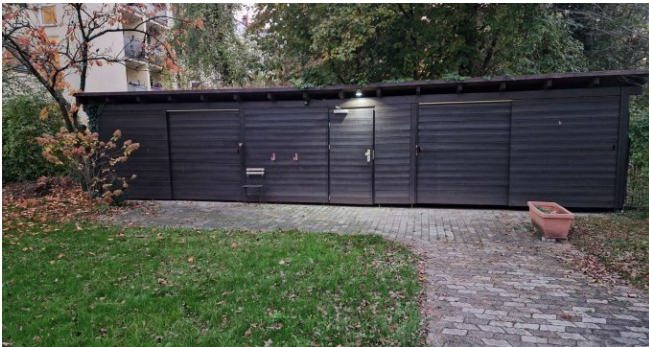
Mülltonnenhaus im Innenhof
